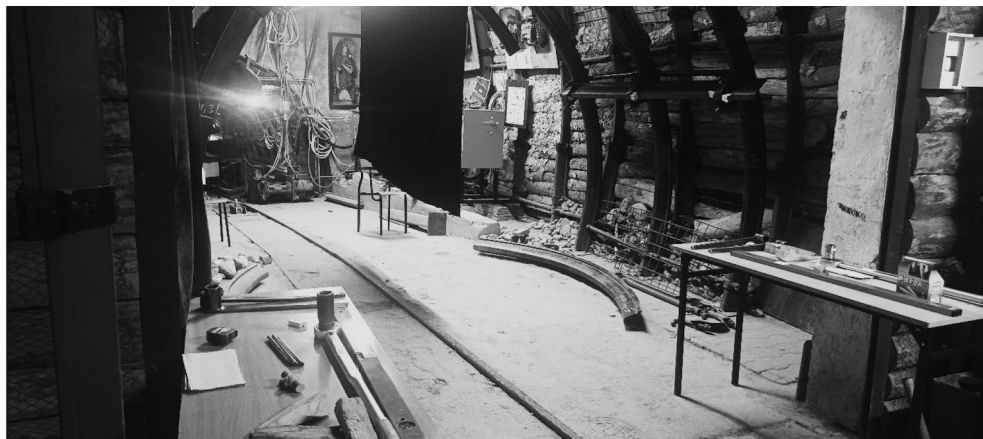
Zdjęcie 1. Tradycyjne stanowiska egzaminacyjne, przygotowane w podziemnej sztolni – widok ogólny (fot. GIG – PIB)
