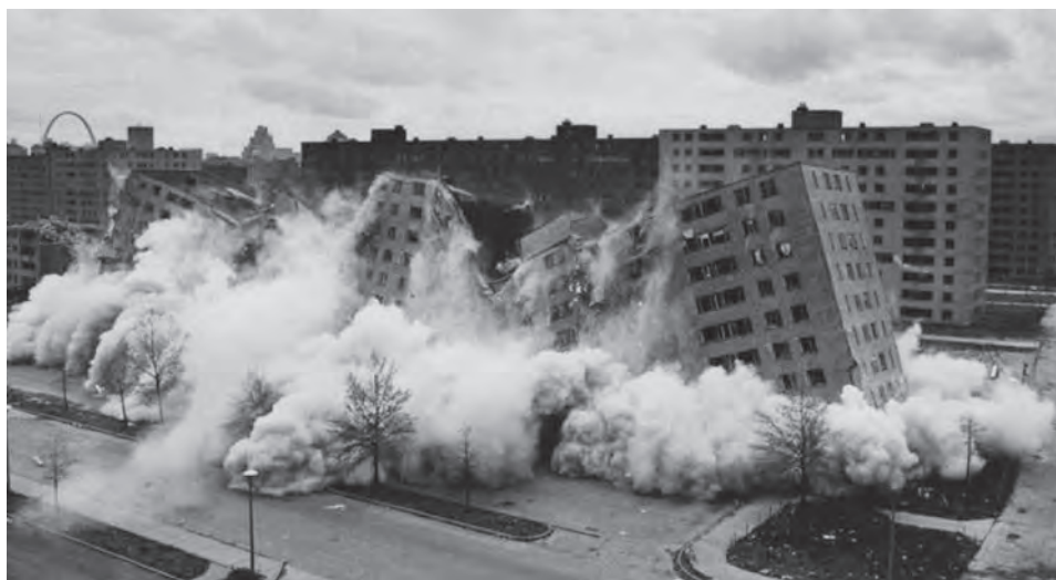
Rys. 1. Symboliczny koniec modernizmu – zburzenie Pruitt-Igoe, St. Louis, USA, rok 1972
